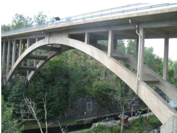
Landsvägsbron som går över akvedukten.
