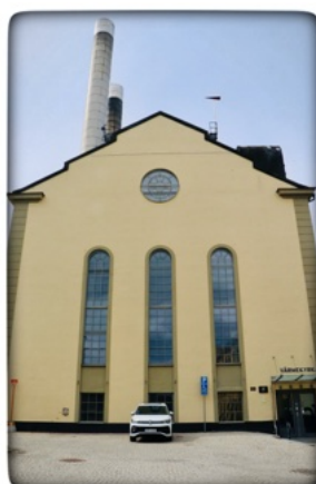
Värmekyrkan, förr ångpannecentral, nu festlokal.
