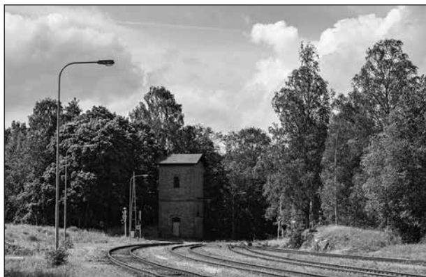
Vattentorn för ångloken vid Bofors station.
