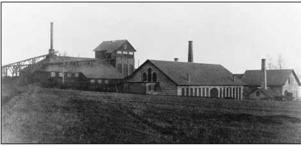
1877 påbörjades murningen vid Bofors av en sur martinugn (kvartsinfodrad) för 5 ton. Den första togs i bruk 1878 och nr 2 började byggas 1885.
