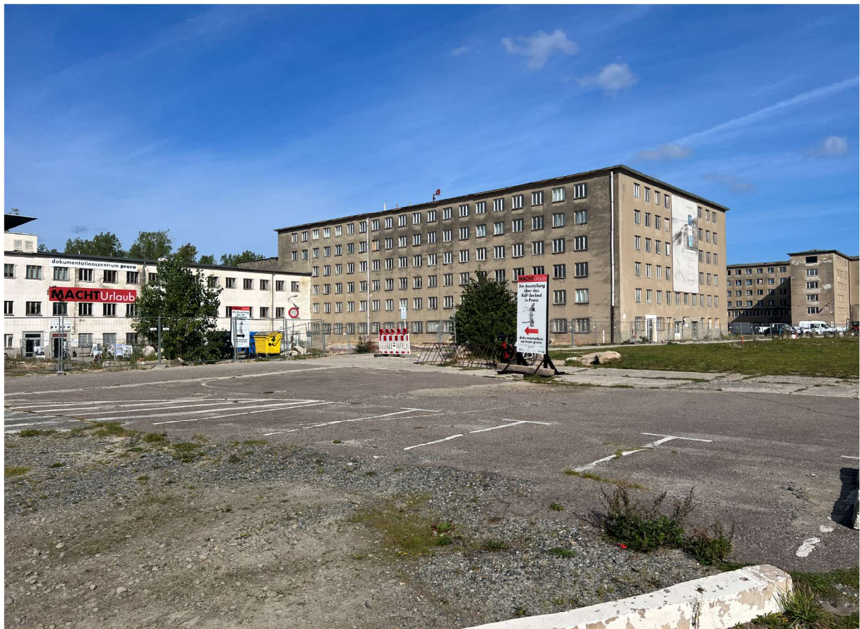
En del av de ursprungliga byggnaderna. Just dessa är väldigt förfallna och håller knappt ihop.
