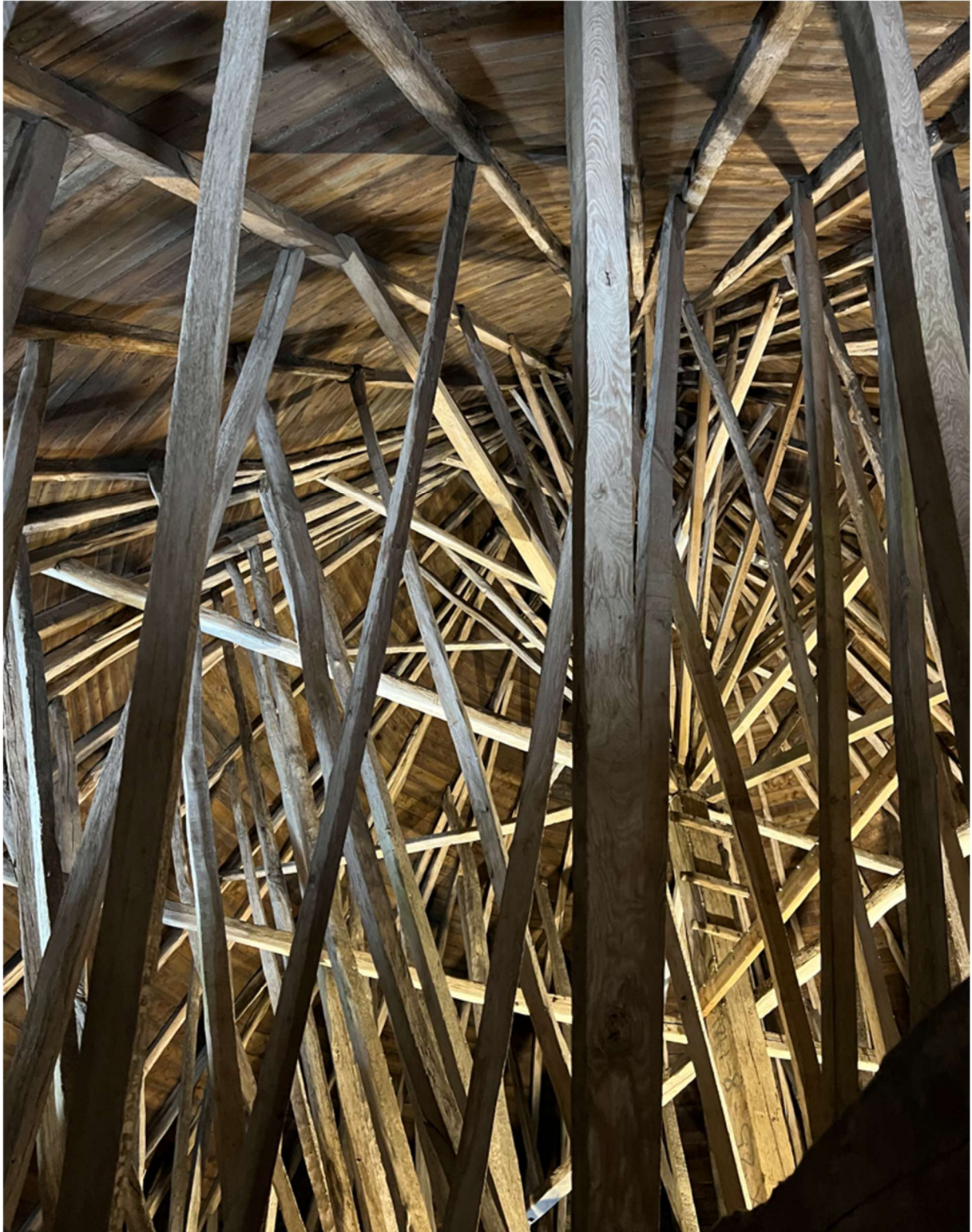
Takkonstruktionen från insidan.
