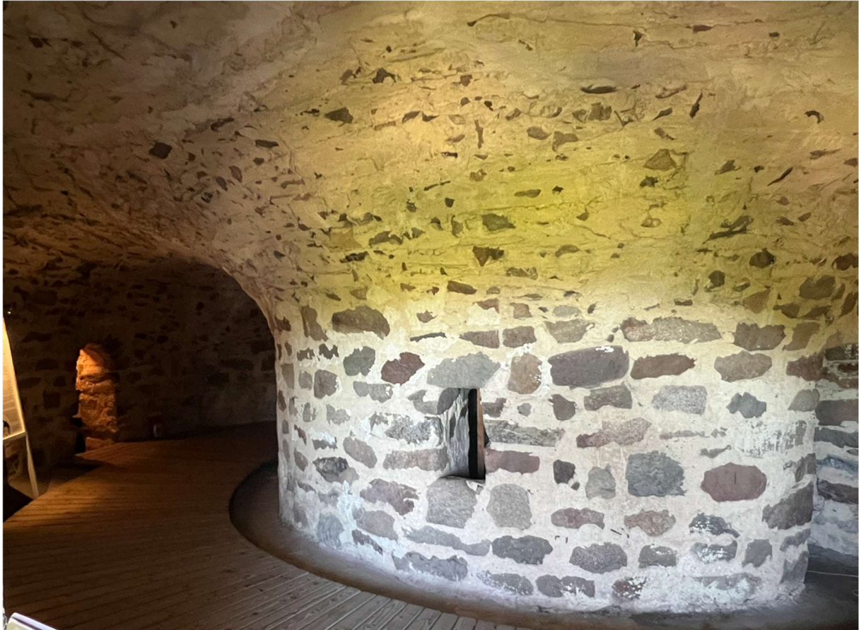
Den tjocka centrumpelaren gick genom hela byggnaden.
