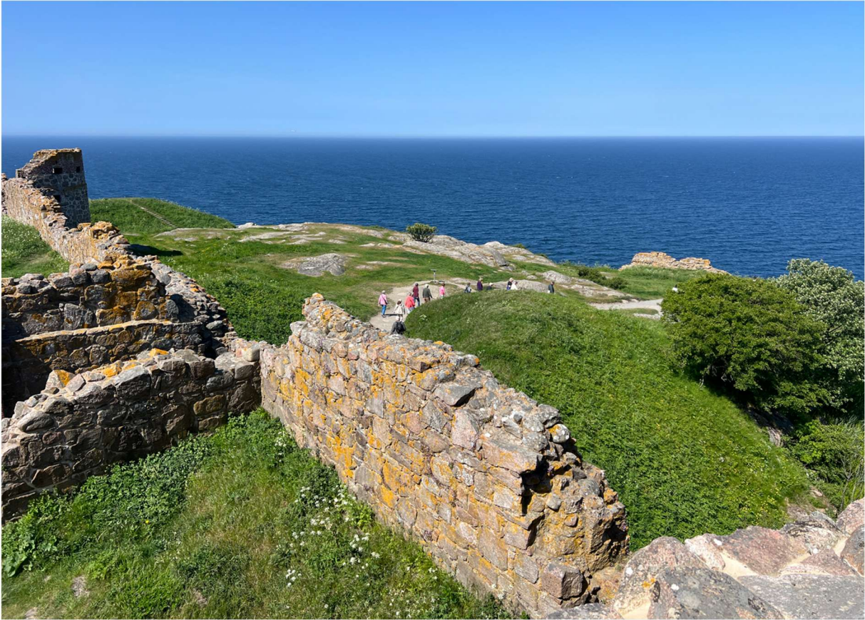
Ett ständigt renoveringsprojekt pågår för att bevara så mycket som möjligt av ruinen.
