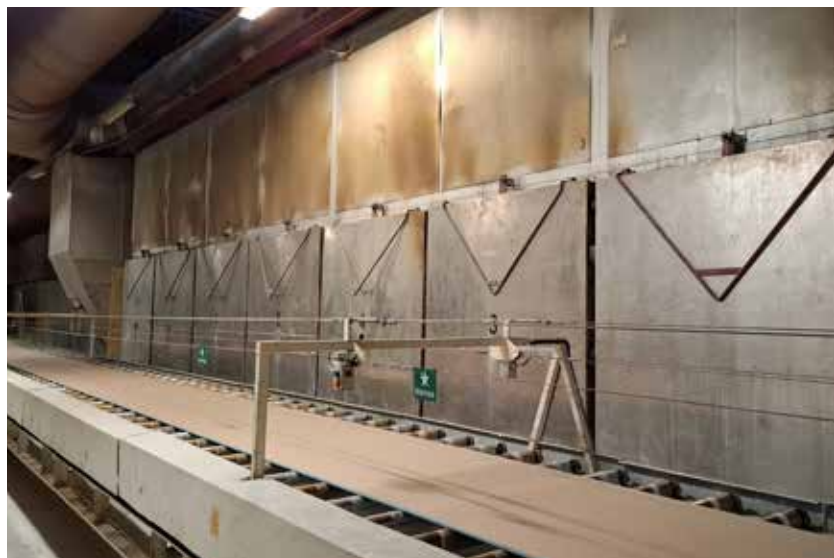
Efter att ha transporterats till andra ändan av maskinen fortsätter transportbandet åt andra hållet och bakom dessa väggar sluttorkas skivorna.
