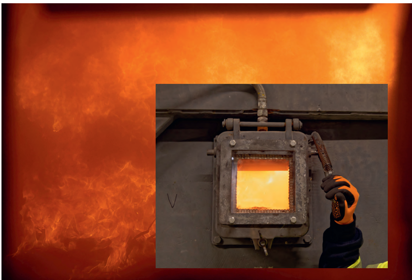
Vy in i helvetets hetta eller förbränningsugnens omvandling av våra sopor till el och värmeenergi I den här inspektionsluckan kunde vi blicka in i det innersta och se hur förbränningen såg ut.
