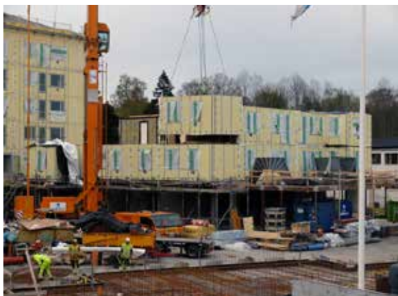
Sollentuna bygger – här montering av prefabricerade rumsenheter på f.d Bilbesiktningen, Frestavägen
