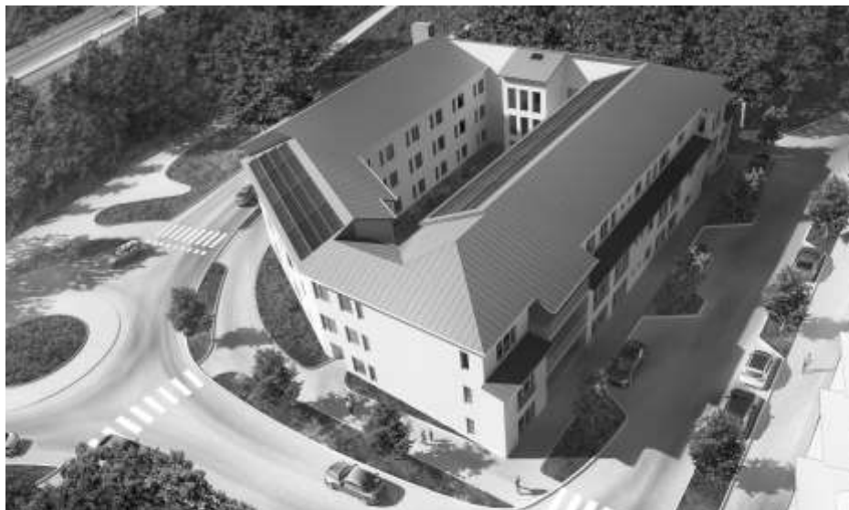
Äldreboendet i Silverdal byggs av Skanska och blir inflyttningsklart hösten 2020.
