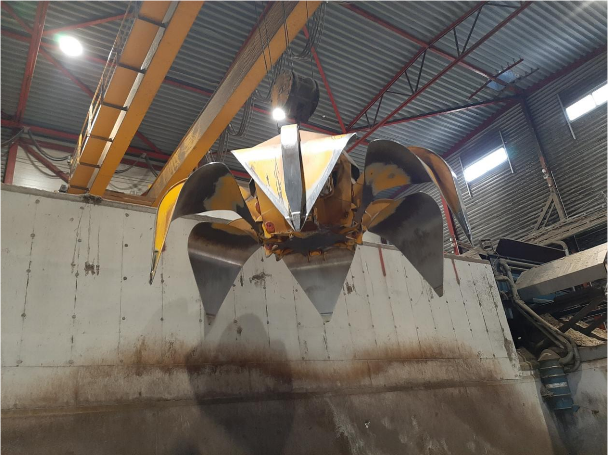
denna enorma datorstyrda gripskopa som sedan släpper materialet i pannan.
