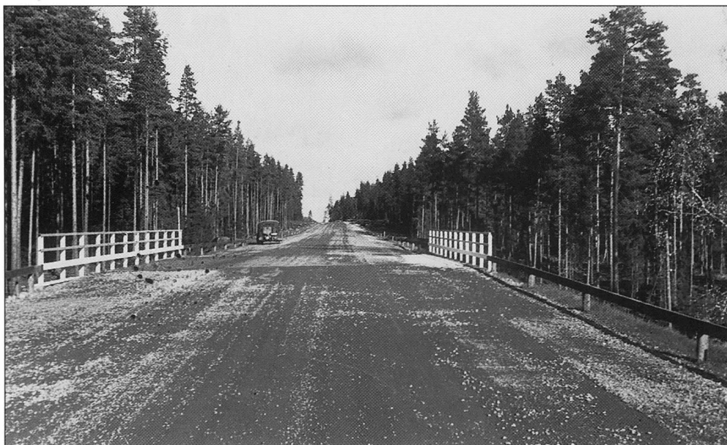
Den nybyggda vägen Falun-Borlänge vid Karlsviksbacken, innan betongläggningen kom på plats, början av 1940-talet.
