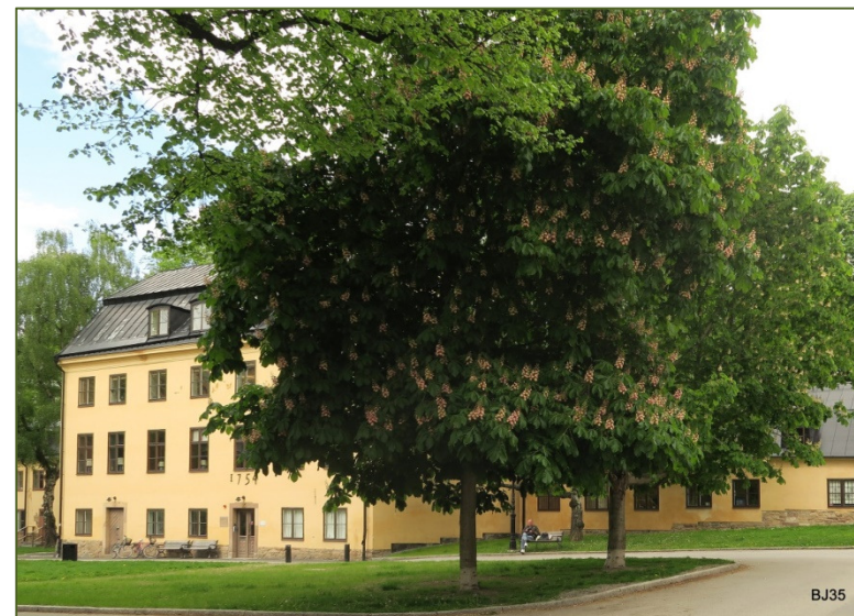
Graverska huset och en röd kastanj
