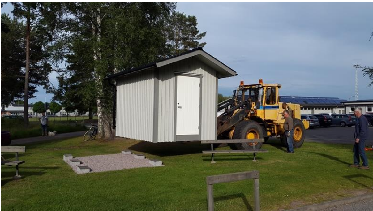
Härovan ses den färdiga byggnaden under transporten till sin placering vid boulebanan.
