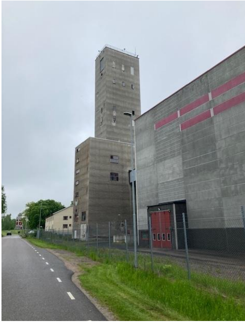
Nya gruvlaven och centralschaktet. Laven är 70 m hög och schaktet under är 620 m djup.
