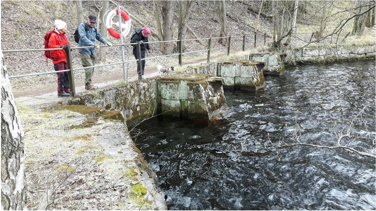
Vattenintaget till turbinerna som drev valsverk mm i Domnarvets Järnverk omkring 1870.
