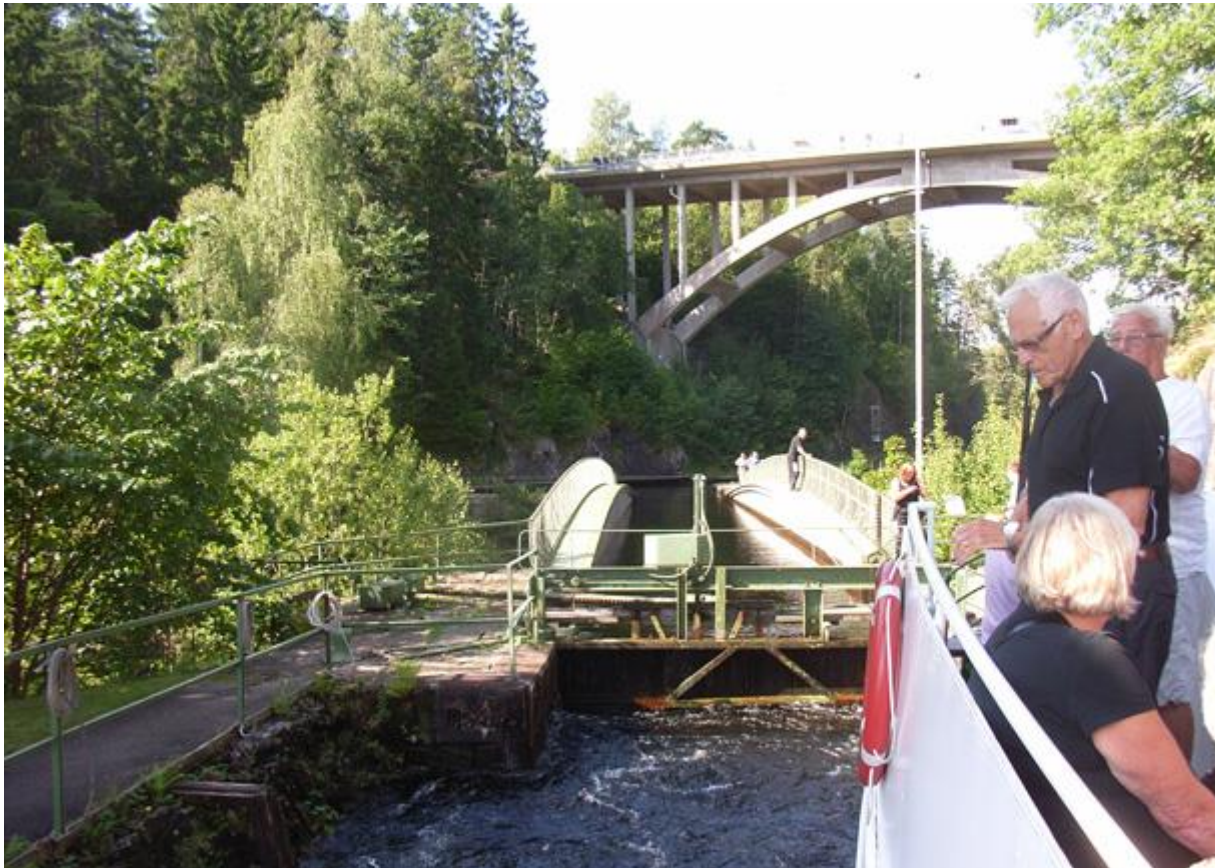
På väg in i akvedukten som byggdes för att komma över en djup forsravin. Det är en stålkonstruktion som är hopsatt med 33000 nitar. Ingen nit har behövt bytas ut.
