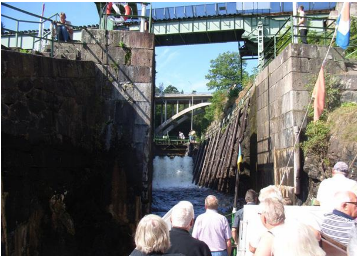
Här är vi på väg in i första slussen. Vid Håverud lyfts vi 9,9 meter i 4 slussar. I bildens överkant syns järnvägsbron och längre bort ligger landsvägsbron.
