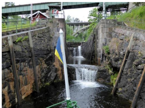
Vattenflöde i slussen
