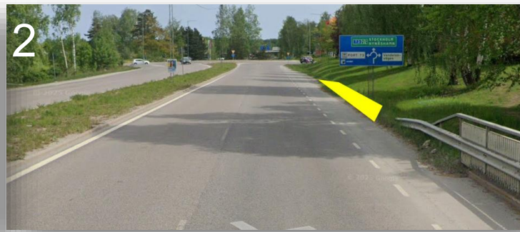
2 Gudöbroleden österut mot riksväg 73 Foto: GoogleMaps
