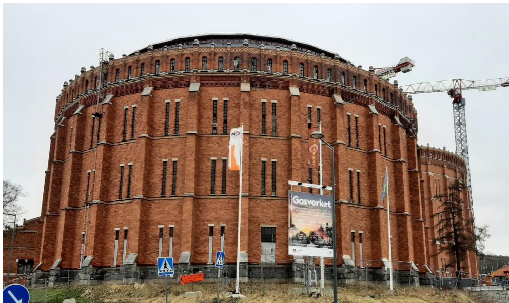
Lite längre bort vid Bobergsgatan finns de två gamla gasklockorna, Ferdinand Bobergs vackra industribyggnader från slutet av 1800-talet.
