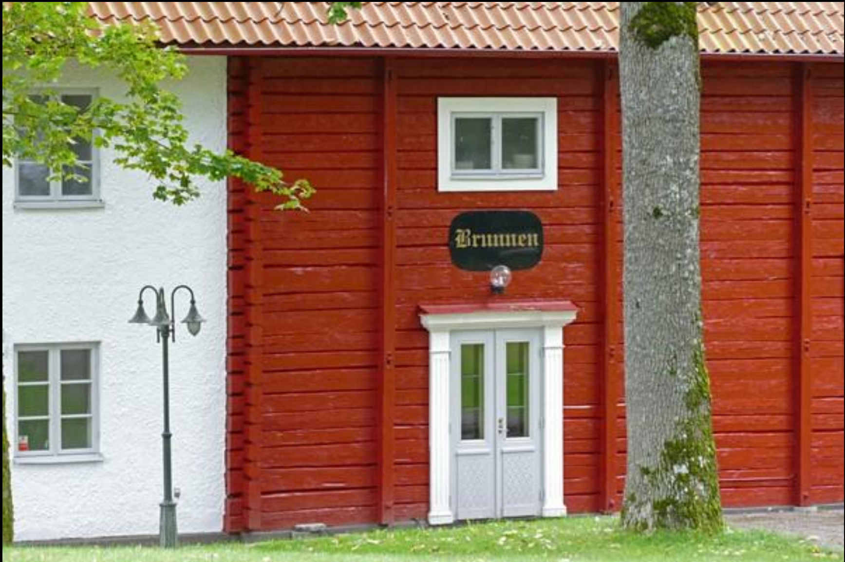
Brunnshuset intill restaurangen.
