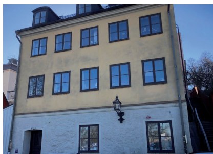
Huset där Fogelström bodde.
