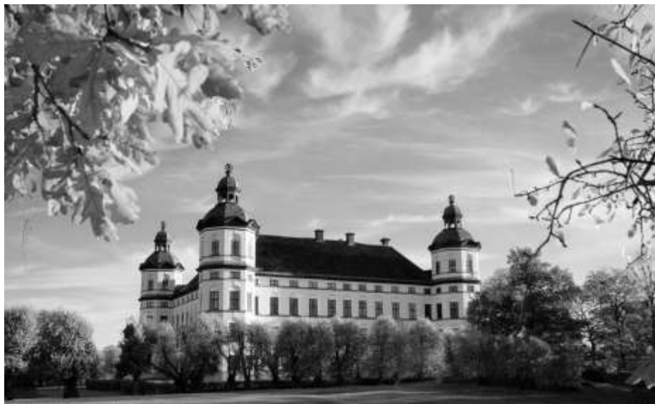
Skokloster, uppf rt 1654–1676,  r det st rsta privatpalats som n gonsin byggts i Sverige.
