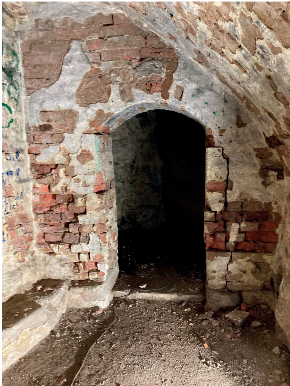
Bild 10. Dörröppningen mot rum 3 sett från rum 2. Foto: A. B.
