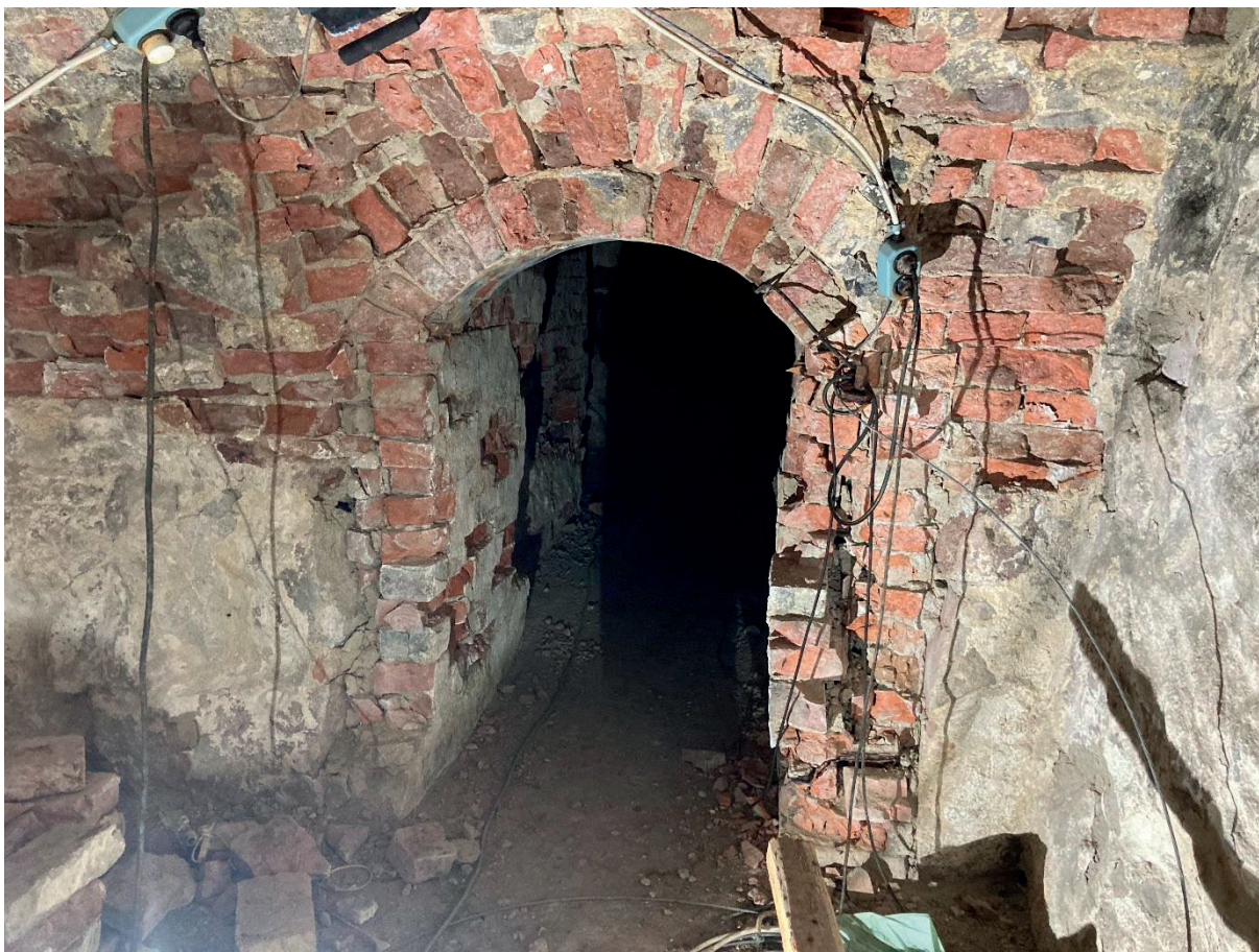
Bild 7. Dörröppningen från rum 1 mot rum 2. Foto: A. B.
