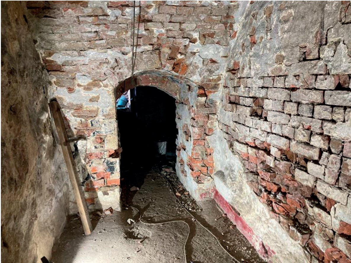
Bild 8. Rum 2 sett mot norr och rum 1. Till höger vetter väggen mot det igensatta trapploppet. Till vänster anas naturstenväggen mot rum 4. Foto: A. B.
