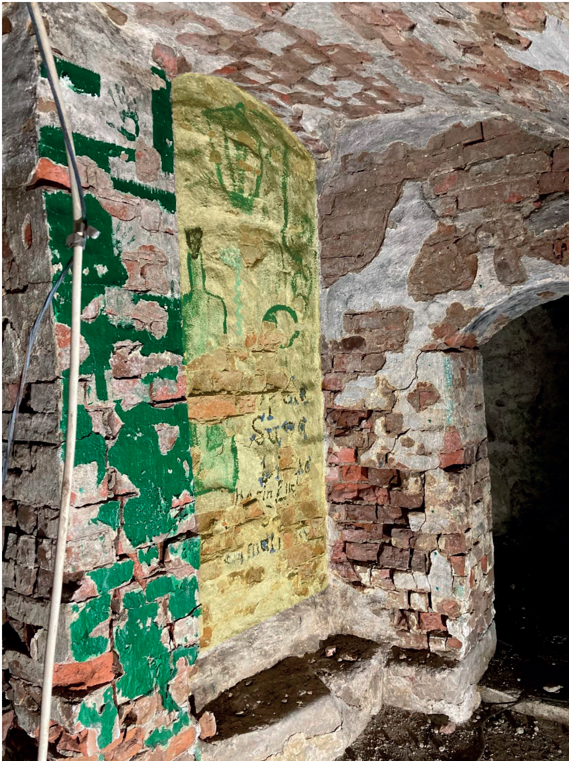
Bild 9. Den igenmurade, välvda dörröppningen till ett trapplopp har på bilden markerats med gult. Till höger leder dörröppningen till rum 3. Foto: A. B.
