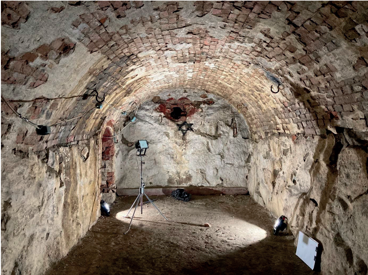
Bild 12. Rum 4 sett mot söder. Till vänster anas dörröppningen mot rum 2, i taket finns spetsiga krokar i rummets mitt. Foto: A. B.
