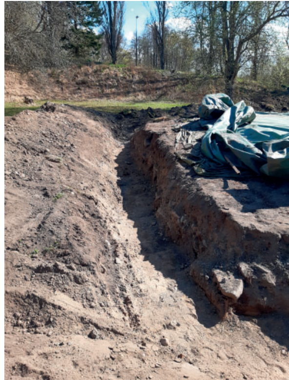
Figur 11. Den östra gaveln av grundmuren till den norra flygelbyggnaden framschaktad. Foto från nordöst.
