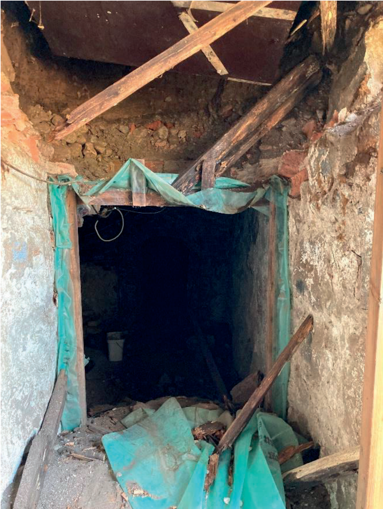
Bild 3. Ingången till rum 1 sett från bottenplanet vid nedgången. Takvalv saknas. Foto: A. B.
